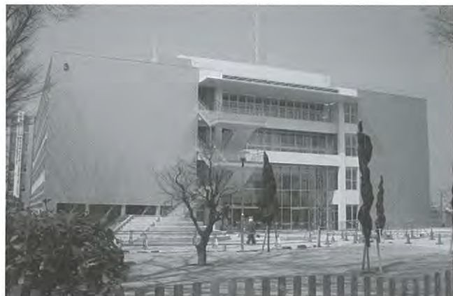
2014年に完成した新3号館（主に講義室） （地中熱利用・太陽光発電・雨水利用など）
