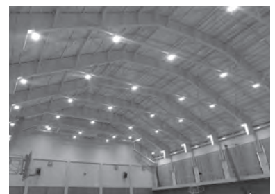
LED改修後の体育館
