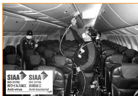
①航空機内の施工風景
