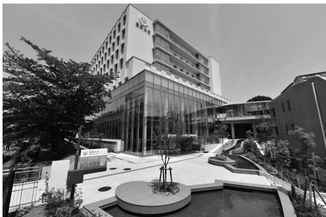
大橋病院の外観
