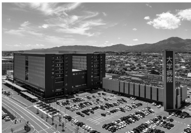
附属病院とエネルギーセンター(右側)
